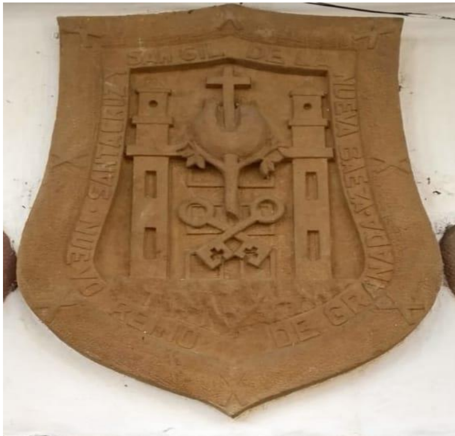
TALLE DEL ESCUDO TALLADO EN PIEDRA UBICADO EN EL FRONTIS DEL PÓRTICO DE LA CASA DE LA CULTURA
